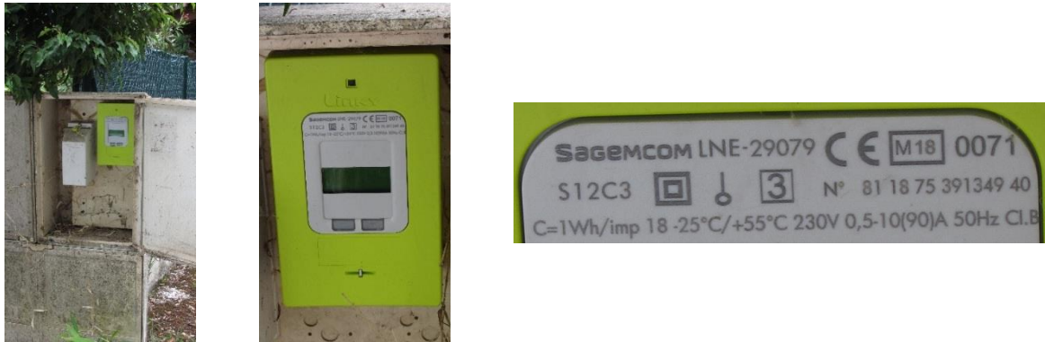
Figure 16 : compteur Linky G3 monophasé et numéros de référence
