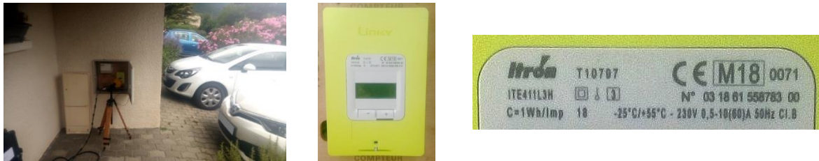
Figure 18 : compteur Linky G3 monophasé et numéros de référence
