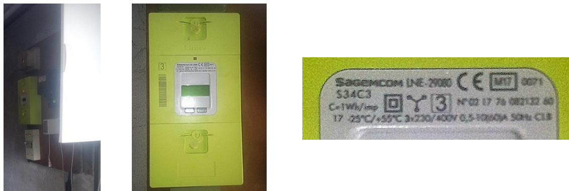
Figure 17 : compteur Linky G3 triphasé et numéros de référence
