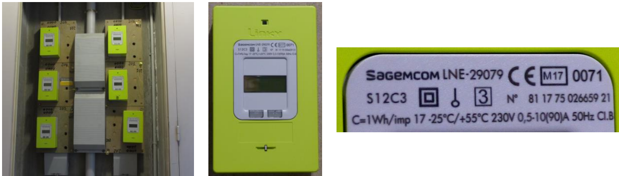
Figure 20 : compteur Linky G3 monophasé et numéros de référence
