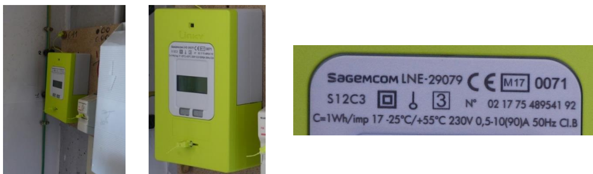
Figure 19 : compteur Linky G3 monophasé et numéros de référence
