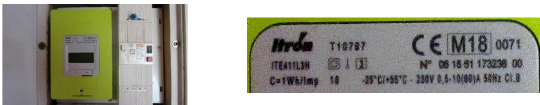
Figure 15 : compteur Linky G3 monophasé et numéros de référence
